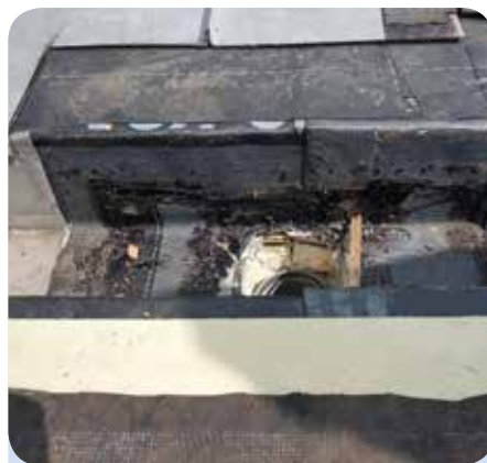
Eine entlang der gesetzten Nieten durchlöchernde Si-Rinne.
