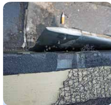
Rückseite der Einlegerinne mit den Nieten und dem Loch in der Si-Rinne.
