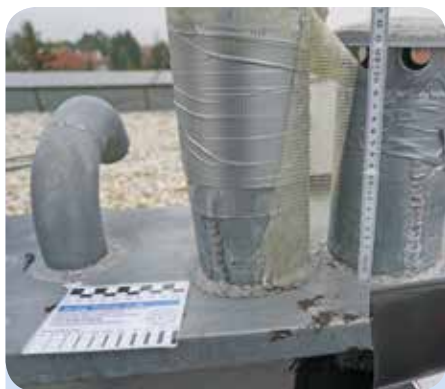
Bild 1: Abklebung mittels Paketklebeband.
