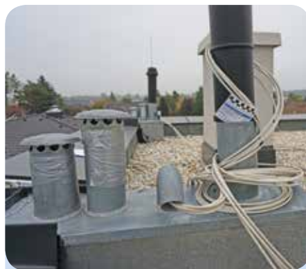
Bild 2: Überlappung des Gegentrichters (am Kunststoffrohr) nicht gegeben.
